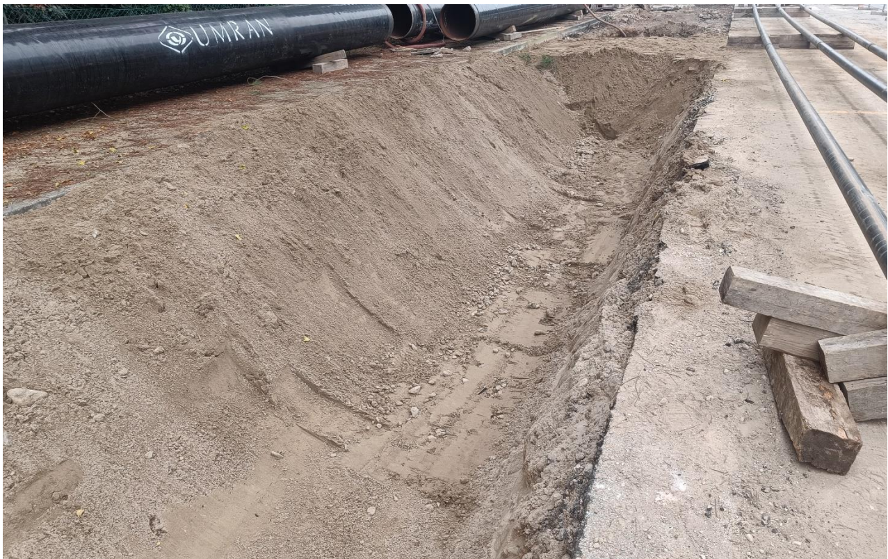
Figura 3 - Trincea di scavo
