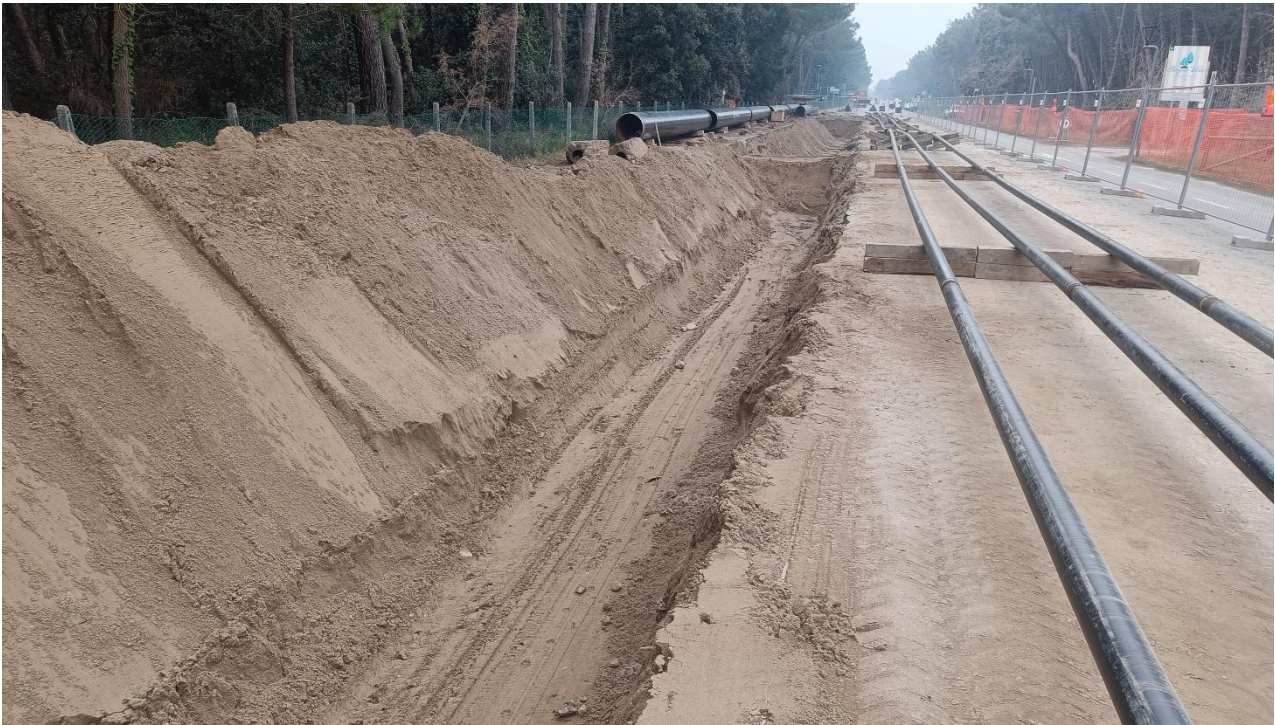
Foto 3.3 – scavo a cielo aperto in sezione ristretta
